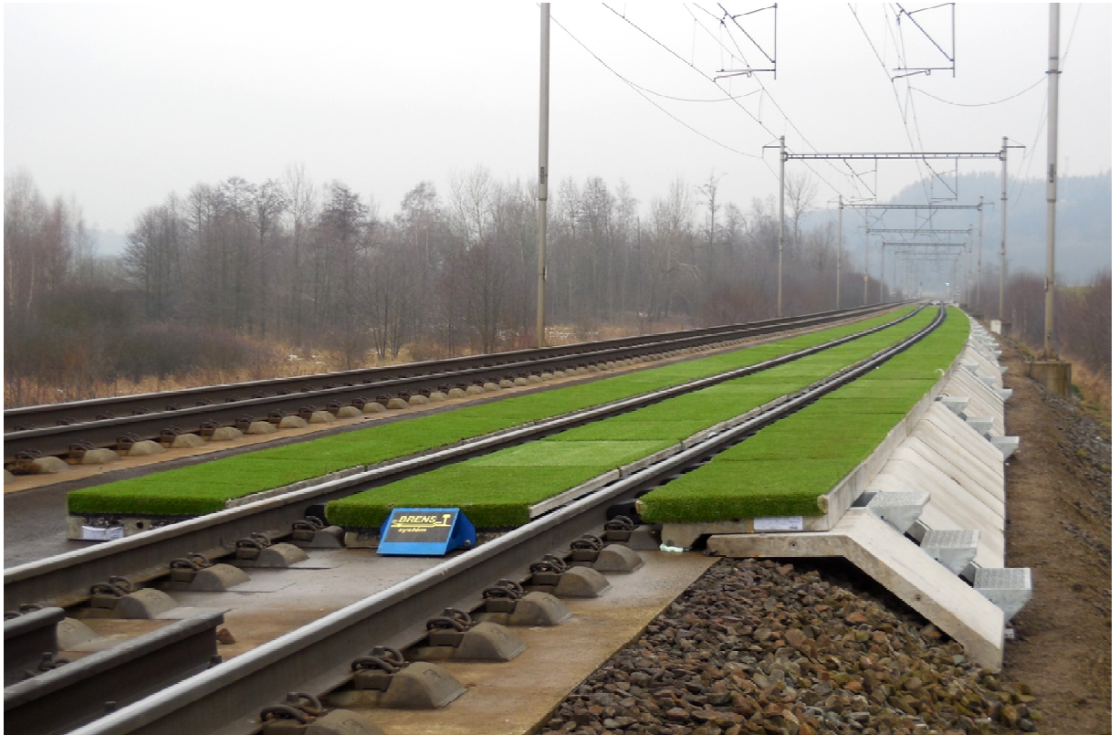
Obrázek 17: POHLED NA DOKONČENÝ SO 2 – KOLEJOVÝ ABSORBÉR BRENS® SE SYNTETICKÝM RECYKLÁTEM A UMĚLÝM TRÁVNÍKEM NA POVRCHU - LEDEN 2015
