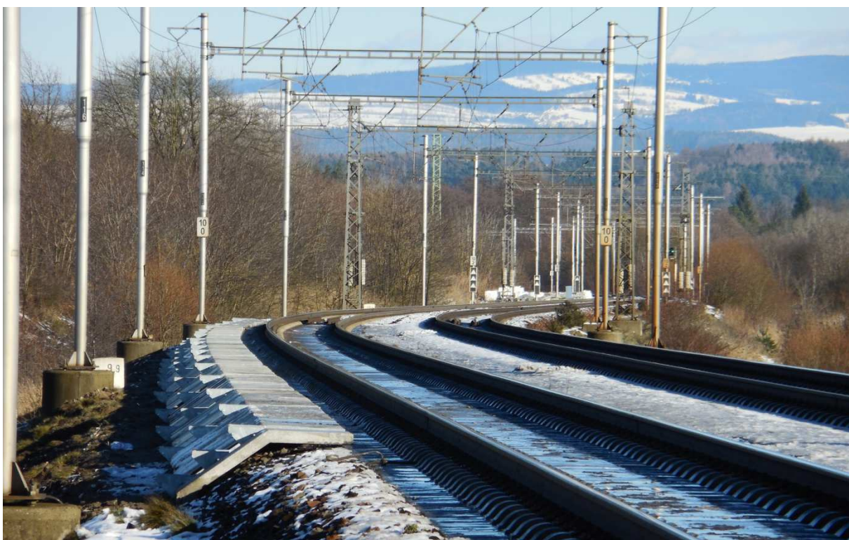
Obrázek 16: POHLED NA PŘIPRAVENOU ČÁST SO 2 PŘED ZAHÁJENÍM MONTÁŽE DÍLCŮ ABSORBÉRŮ SE SYNTETICKÝM RECYKLÁTEM A UMĚLÝM TRÁVNÍKEM NA POVRCHU - LEDEN 2015
