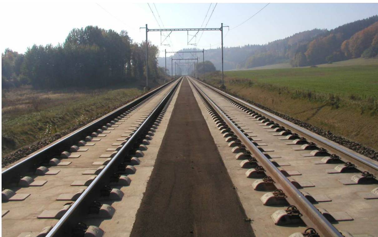
Obrázek 4: POHLED NA KOLEJ S PEVNOU JÍZDNÍ DRÁHOU RHEDA 200 – ŘÍJEN 2007 VE SMĚRU OD RUDOLTIC
