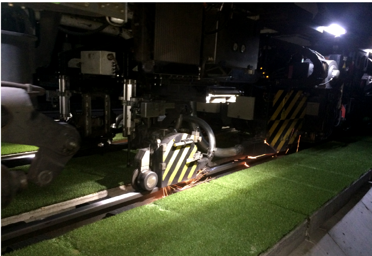
Obrázek 19: POHLED NA KOLEJOVÝ ABSORBÉR BRENS® SE SYNTETICKÝM RECYKLÁTEM A UMĚLÝM TRÁVNÍKEM NA POVRCHU PŘI PROVÁDĚNÍ REPROFILACE A BROUŠENÍ HLAV KOLEJNIC – BŘEZEN 2015
