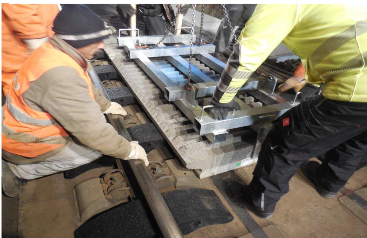
Obrázek 13: VKLÁDÁNÍ VNITŘNÍHO DÍLCE ABSORBÉRU SO1 – 26.11.2014
