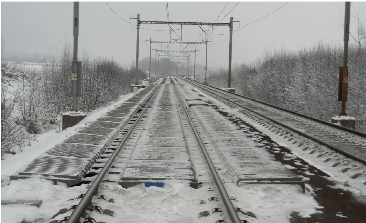
Obrázek 15: POHLED NA ČÁST ABSORBÉRŮ SO 1 PŘED ZAHÁJENÍM DRUHÉ MONTÁŽNÍ KAMPANĚ LEDEN 2015
