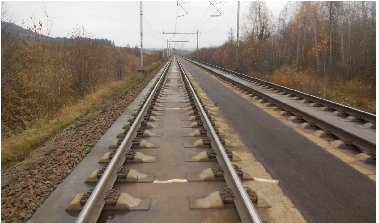
Obrázek 10: POHLED NA TRÁŽ S PJD RHEDA 2000 VE SMERU OD TŘEBOVIC V ČECHÝCH PŘI PASPORTIZACI STAVU KOLEJE PŘED ZAHÁJENÍM MONTÁŽE ABSORBÉRŮ – LISTOPAD 2014.
