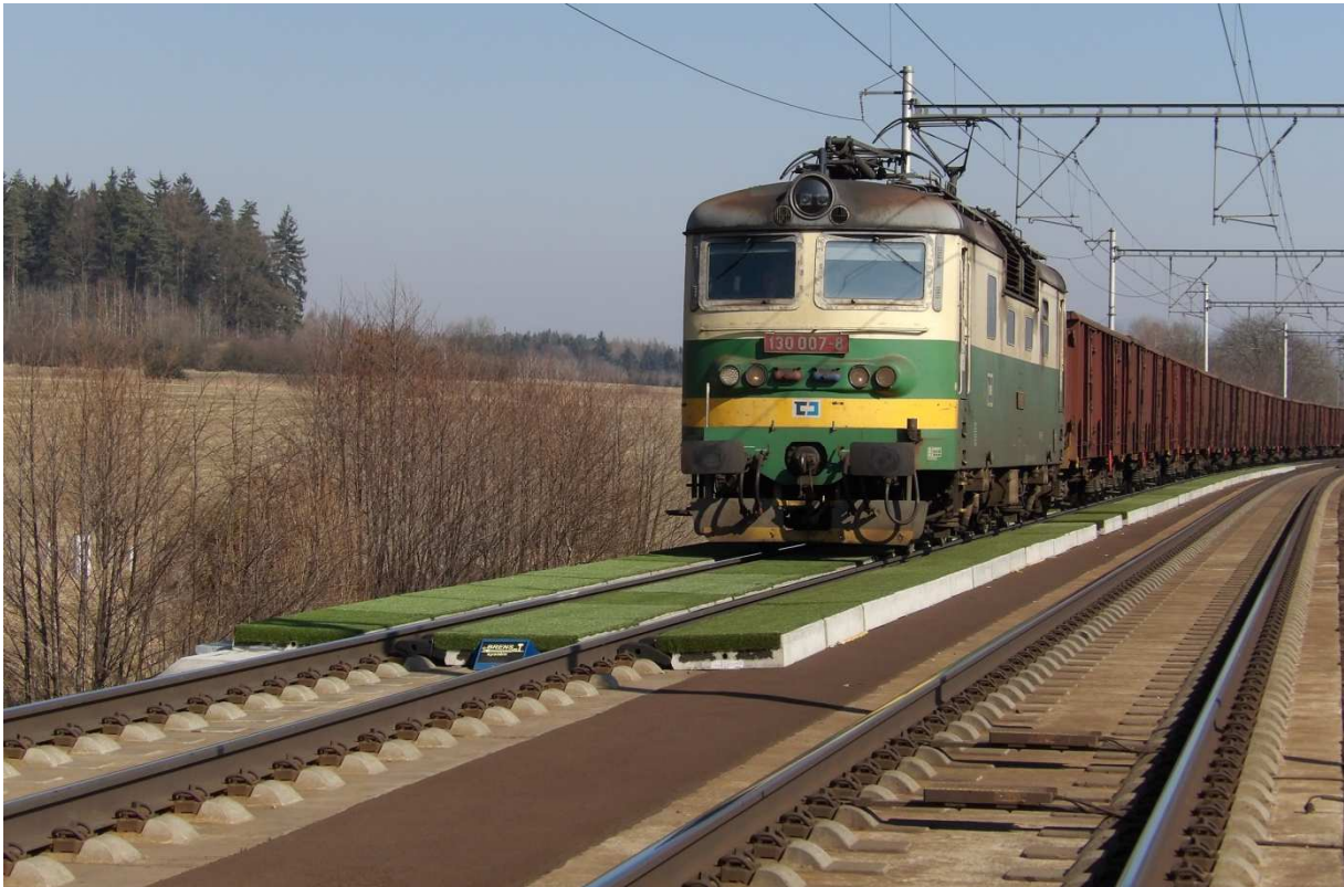
Obrázek 18: POHLED NA KOLEJOVÝ ABSORBÉR BRENS® SE SYNTETICKÝM RECYKLÁTEM A UMĚLÝM TRÁVNÍKEM NA POVRCHU PŘI PROVÁDĚNÍ MĚŘENÍ EFEKTIVITY ÚTLUMU – BŘEZEN 2015
