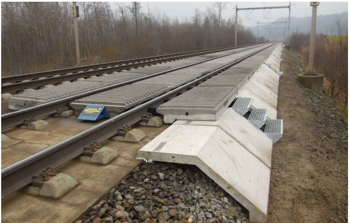
Obrázek 18: POHLED NA DOKONČENÝ SO 1 – KOLEJOVÝ ABSORBÉR BRENS® Z MEZEROVITÉHO BETONU - LEDEN 2015
