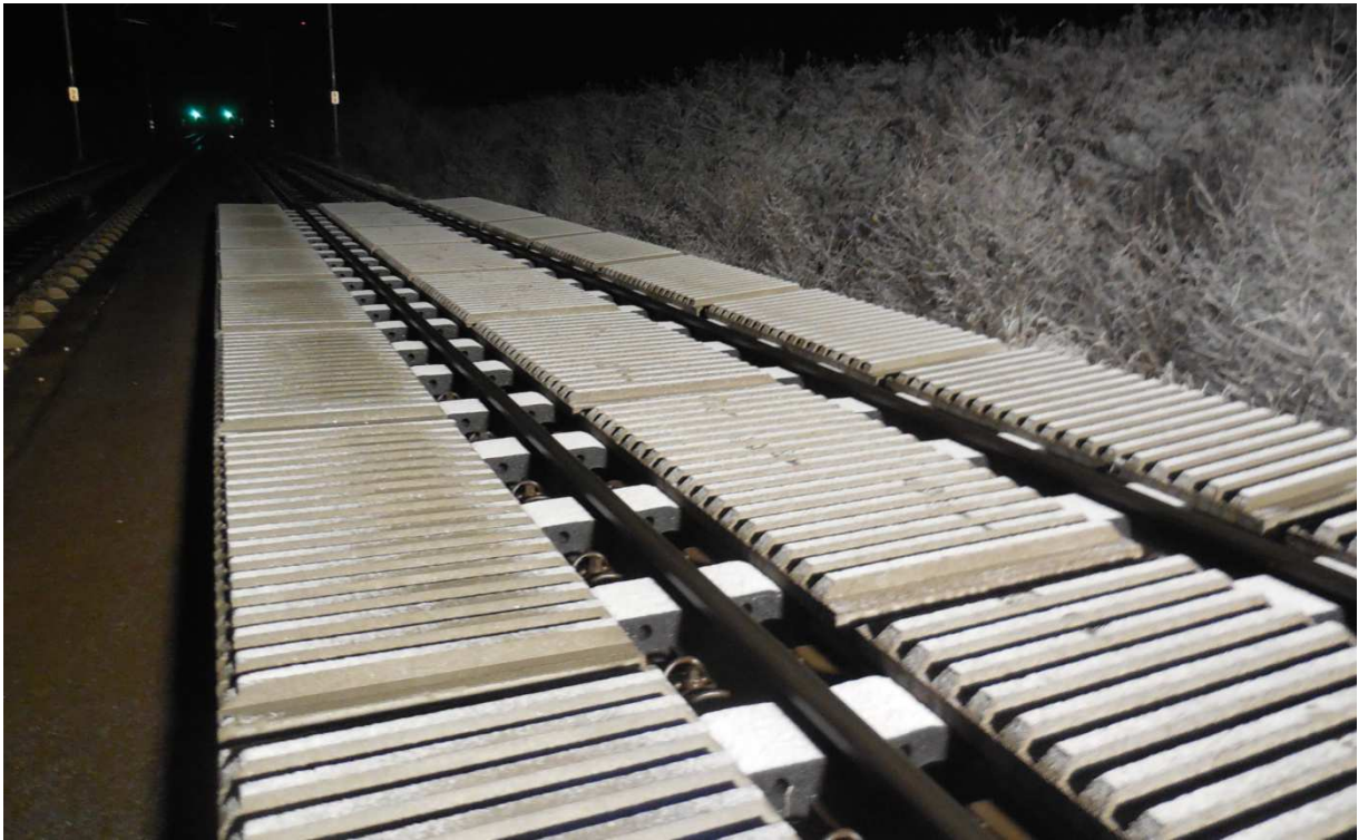
Obrázek 14: POHLED NA ČÁST ABSORBÉRŮ SO 1 – NOČNÍ VÝLUKA 27. - 28.11.2014
