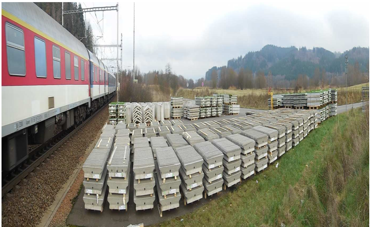
Obrázek 10: POHLED NA TRÁŽ S PJD RHEDA 2000 VE SMERU OD TŘEBOVIC V ČECHÝCH PŘI PASPORTIZACI STAVU KOLEJE PŘED ZAHÁJENÍM MONTÁŽE ABSORBÉRŮ – LISTOPAD 2014.
