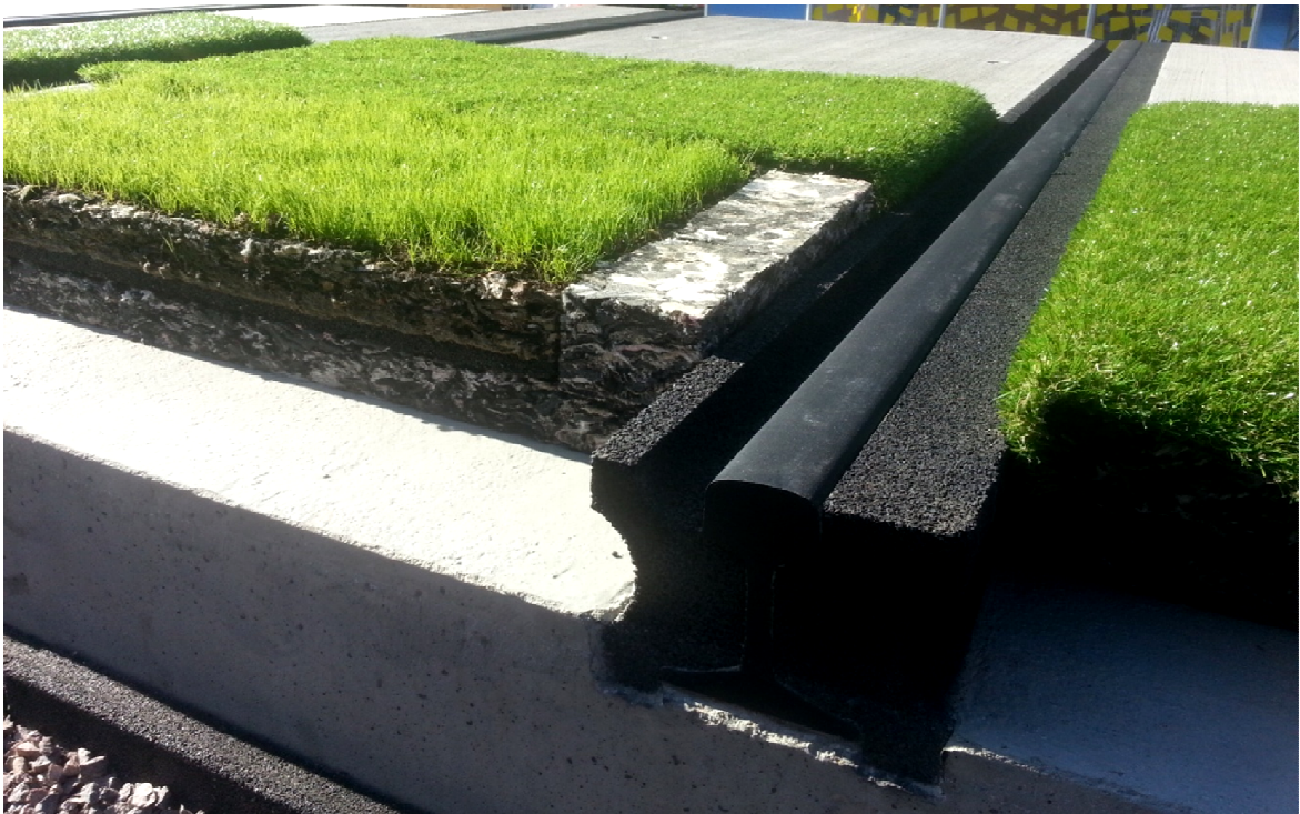
Obrázek 12: FOTOGRAFIE DETAILU PEVNÉ JÍZDNÍ DRÁHY S KONTINUÁLNĚ ULOŽENOU KOLEJNICÍ S49 SE SYNTETICKÝM RECYKLÁTEM OSETÝM PŘÍRODNÍM TRÁVNÍKEM UVNITŘ KOLEJE (V POPŘEDÍ) A S UMĚLÝM TRÁVNÍKEM NA VELETRHU DRÁŽNÍ TECHNIKY CZECH RAILDAYS 2014 OSTRAVA – VÝSTAVNÍ EXPOZICE ŽPSV UHERSKÝ OSTROH
