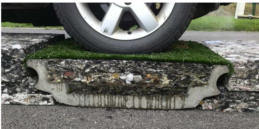
Obrázek 11: DETAIL PROVEDENÍ VNITŘNÍHO DÍLCE ABSORBÉRU BRENS PRO ROZCHOD 1000 MM PŘI PŘEJEZDU OSOBNÍHO VOZIDLA
