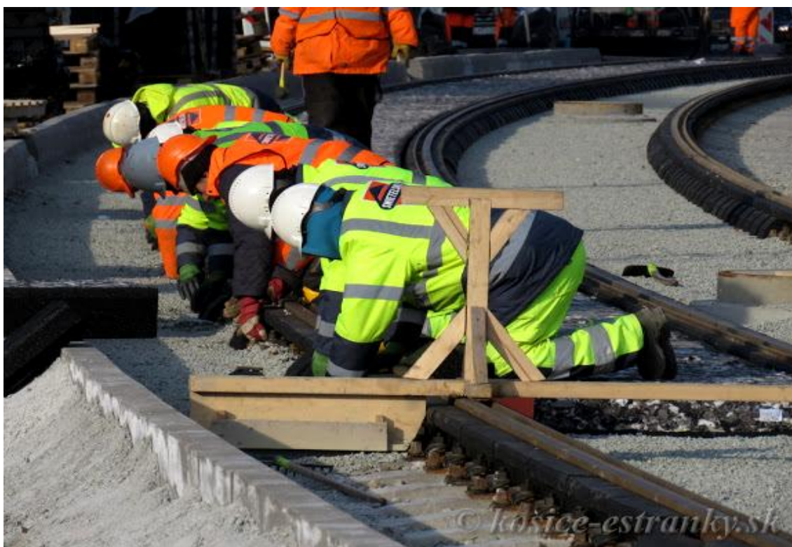
MONTÁŽ ABOSRBÉRŮ zdroj: www.kosice-estranky.sk
