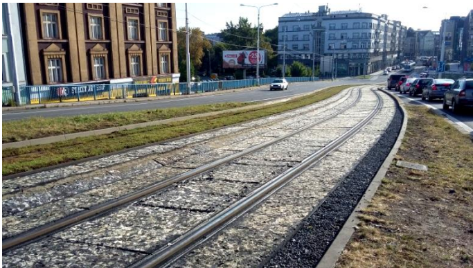
Obrázek 13: Pohled na bod obratu směrových oblouků kolejí s převýšením
