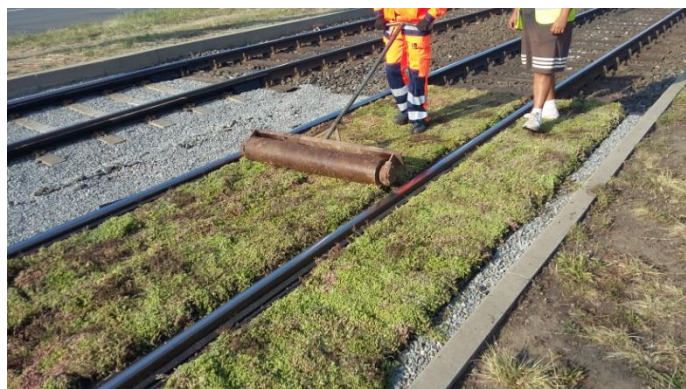
Obrázek 10: Urovnání povrchu rozchodníků ocelovým válcem
