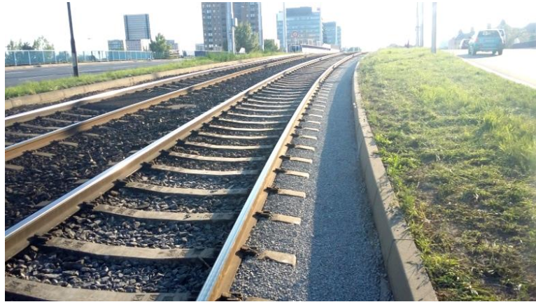
Obrázek 6: Úprava figury štěrkového lože vsypáním štěrku frakce 13/32
