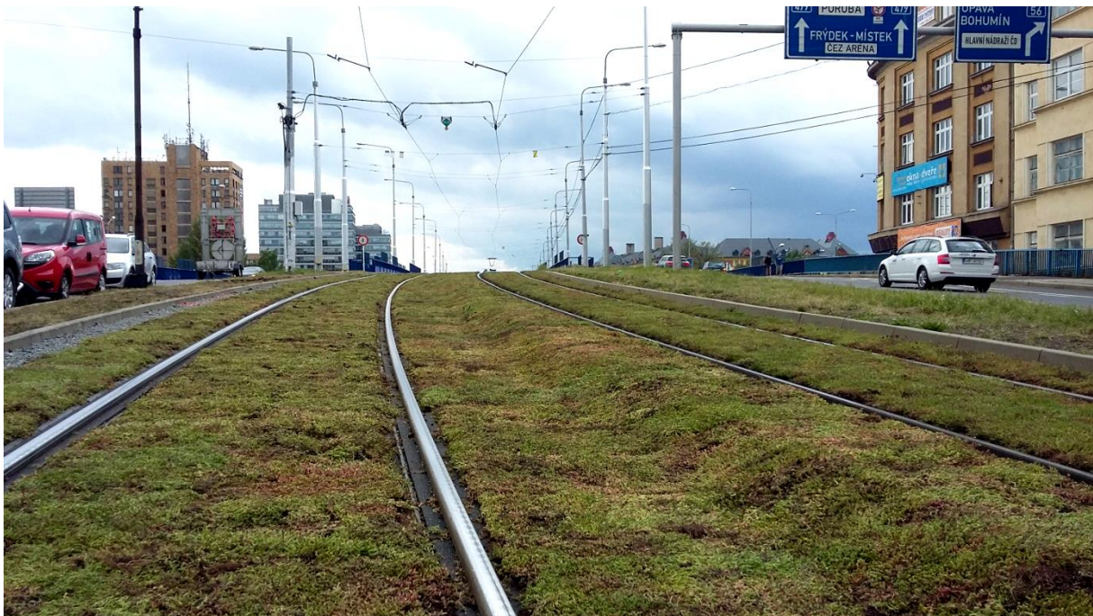
Obrázek 15: Pohled na vegetační povrch kolejového absorbéru ze syntetického a pryžového recyklátu (srpen 2017)
