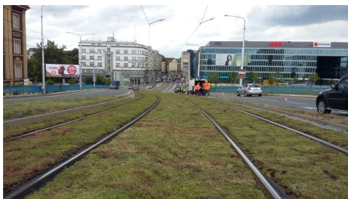
Obrázek 14: Finální úprava koberců povrchu s rozchodníky
