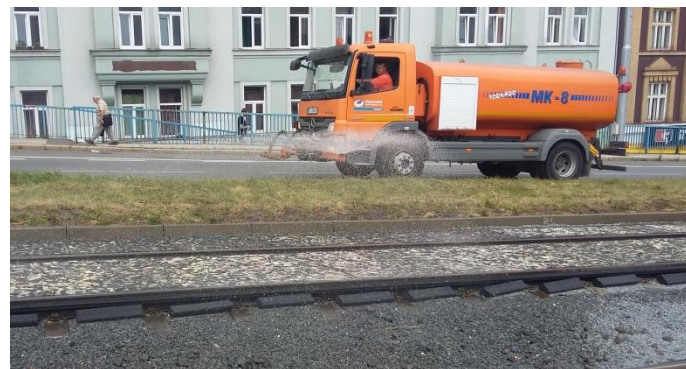
Obrázek 8: Kropení povrchu před výsadbou rozchodníků
