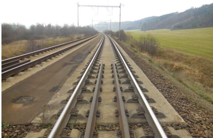
Obr. 1 Pevná jízdní dráha RHEDA 2000 před instalací absorbérů hluku
