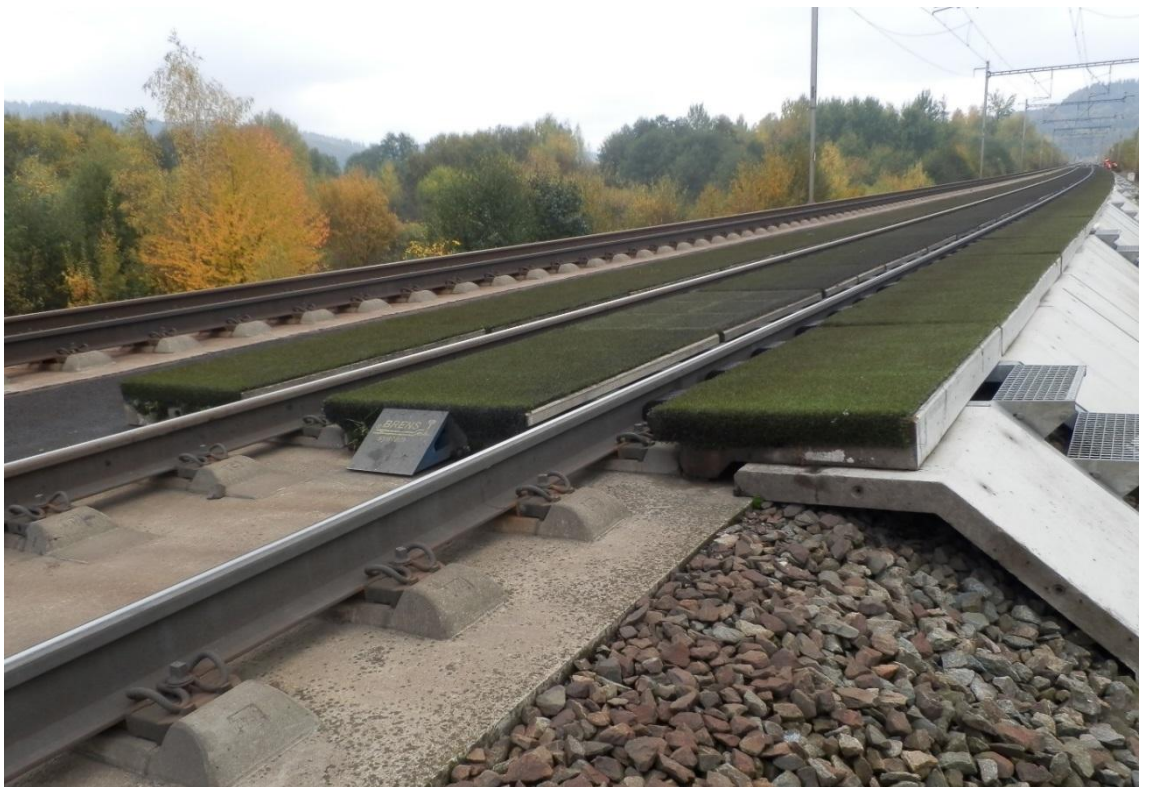
Obr. 2 Kolejový absorbér hluku s umělým trávnikem BRENS, typ BA-S
